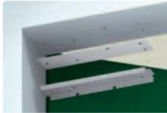
Ubicar la plantilla de montaje debajo del dintel, perforar donde se indica y fijar la base.
